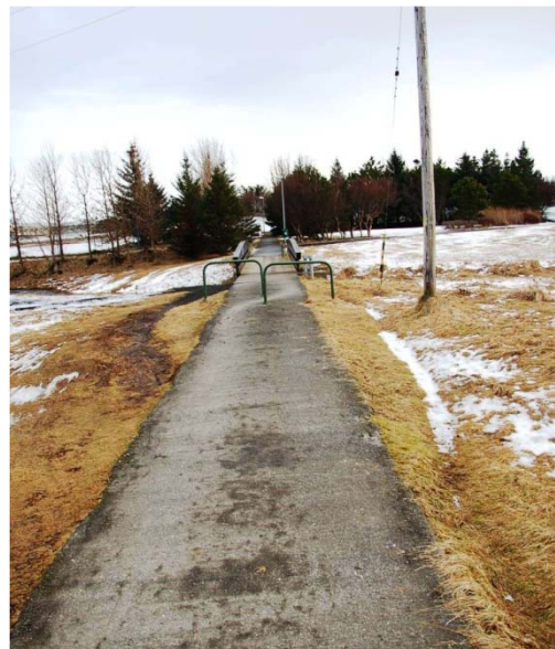
Mynd 16: í Garðabæ. Þrengingar á hjólaleið eftir hitaveitustokk. Umtalsverð hindrun fyrir hjólreiðafólk (hindranir: --). Engin lýsing (lýsing: --).
